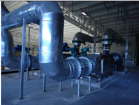
注液前烘干废气处理设施
