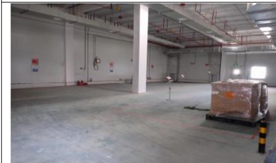
FD3 危废仓防渗、分期存放
